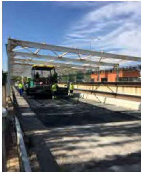
Extendido mezclas bituminosas
