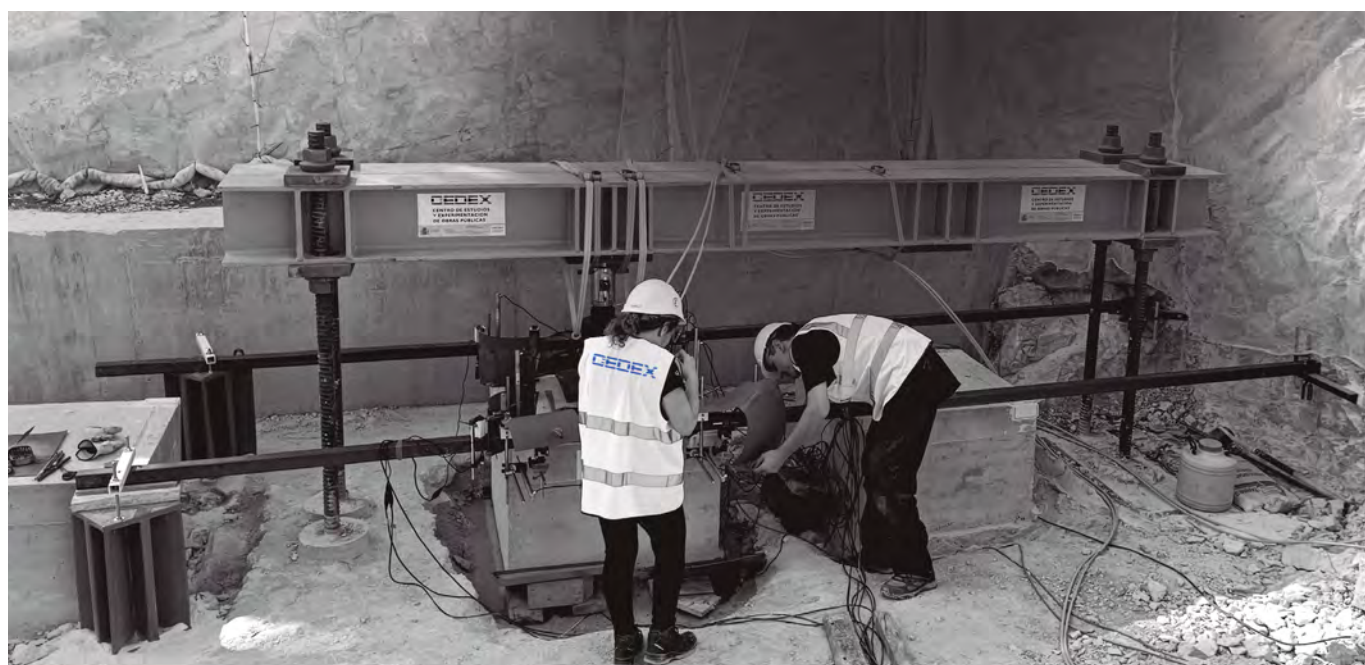
Trabajos en la presa del Amadorio
