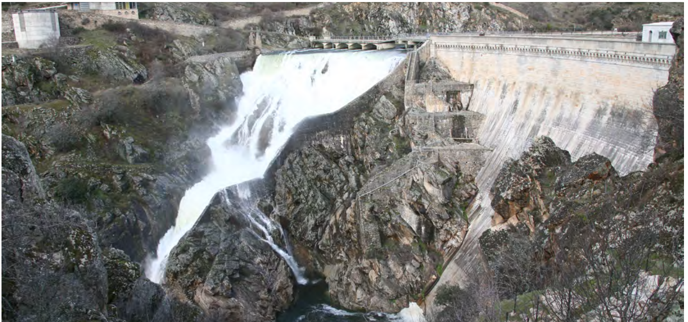
Aliviadero de la presa de El Villar
