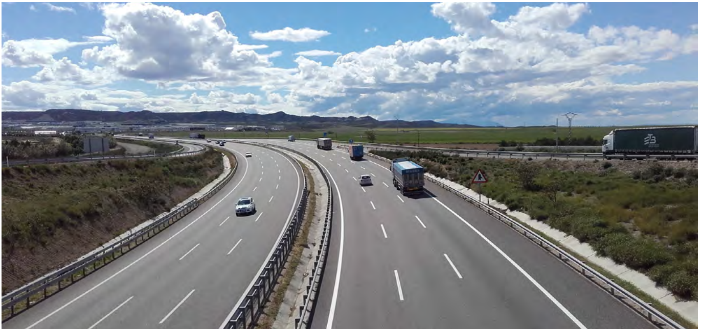
Concesión de la A-2 en la provincia de Zaragoza
