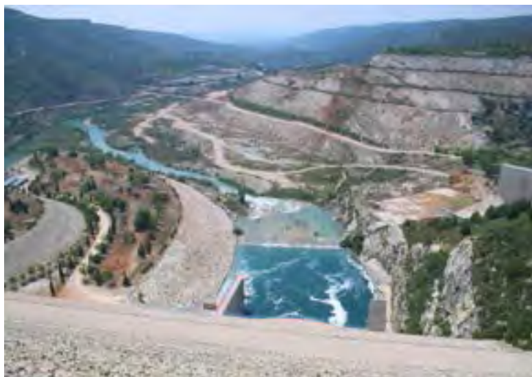
Acuífero kárstico de la margen derecha del río Júcar inmediatamente aguas abajo del embalse de Tous.
