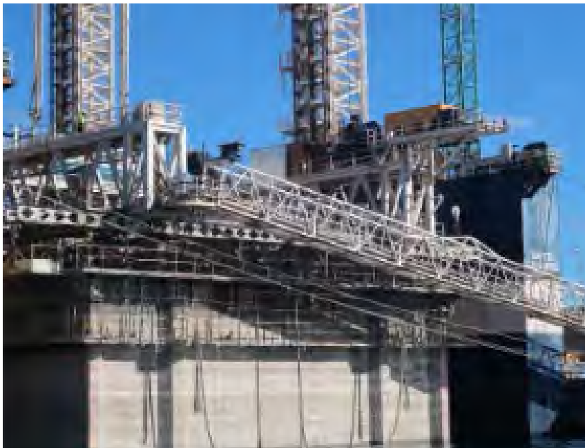
Fabricación en un cajón flotante
