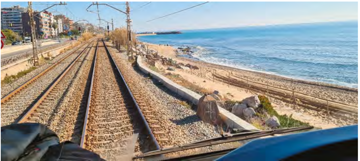
Tramo de la vía del Maresme
