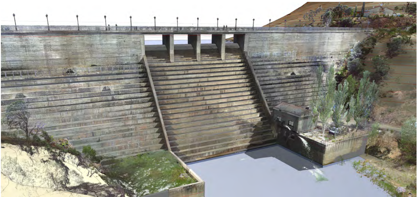
Vista general del modelo virtual, superponiendo la nube de puntos 3D y el modelo BIM
