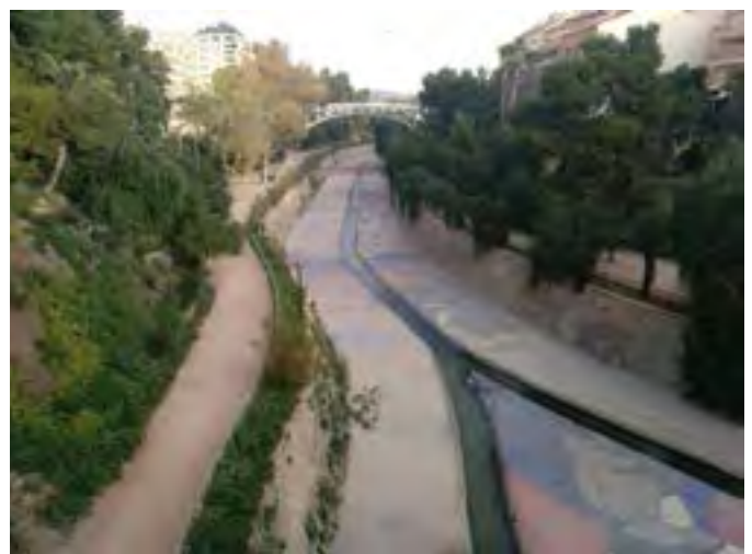
Sección revestida de hormigón en el río Vinalopó a su paso por el tramo urbano de Elche (enero 2020)
